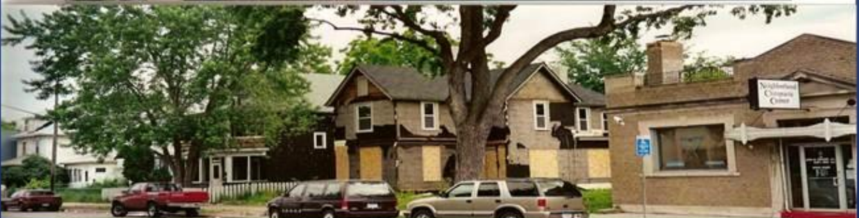
East Phillips Commons Before
